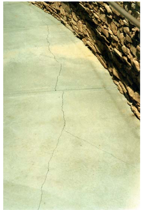
FIGUUR 1.6 Droogscheur in beton (oppervlaktесheur in voetpad, met stortnaad)
