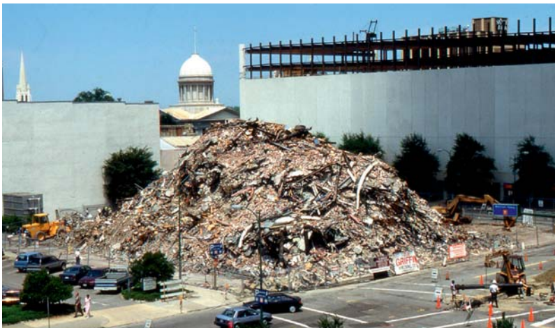
FIGUUR 1.10 Sloopafval via implosie
